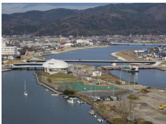
漫画館奥に架けられ新橋梁
