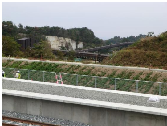
土砂搬出用のベルトコンベアー
