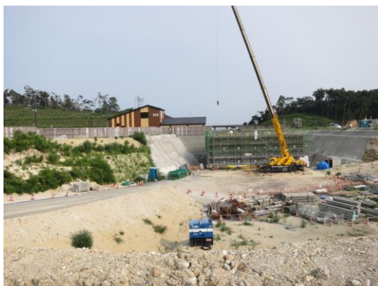
野蒜駅付近の造成工事
