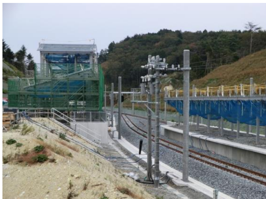
建設中の新野蒜駅
