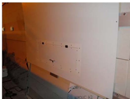
写真-2 トンネル断熱漏水防止版
