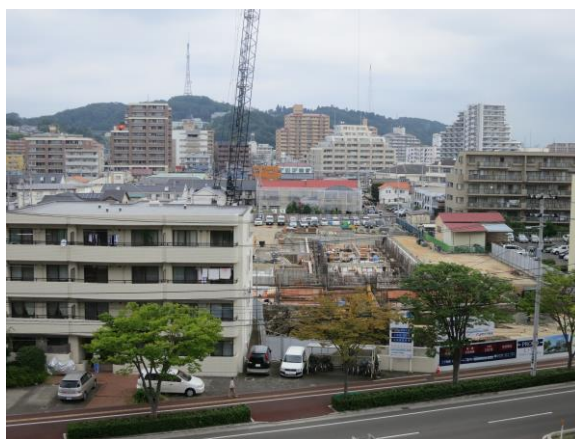
マンション建設が始まる
