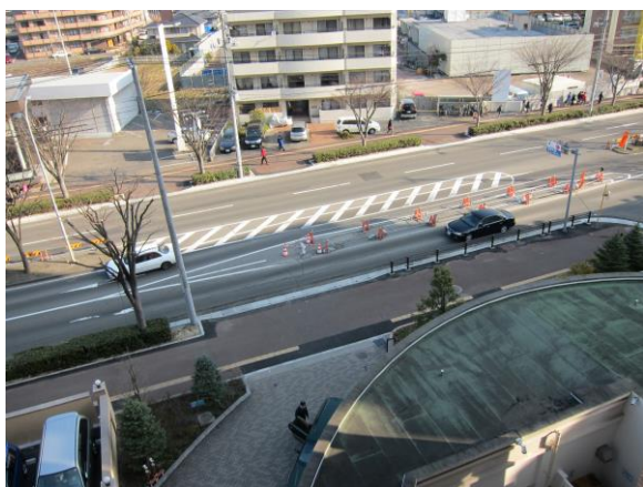
日本郵政(JP)の寮の跡地 取り壊し (右上)
