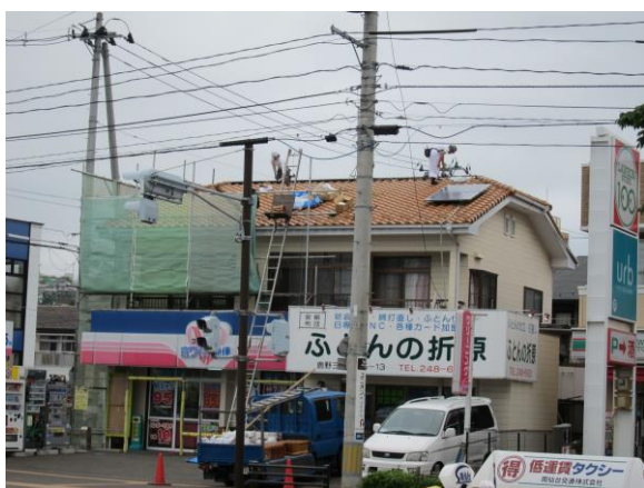
屋根を補修した店舗
