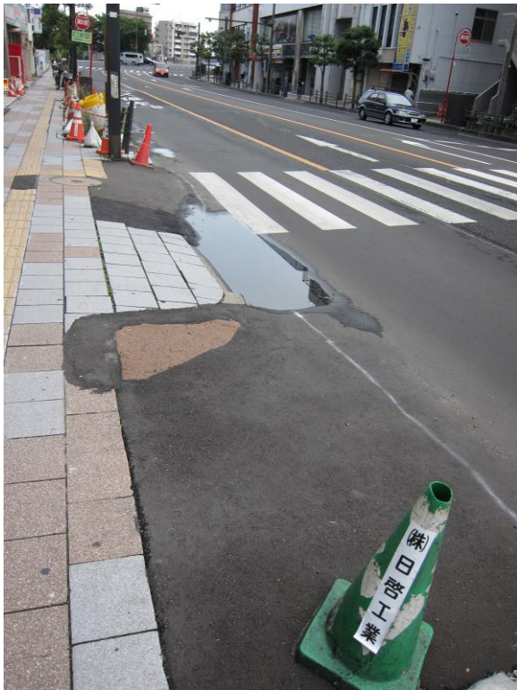
側溝が埋められた道路
