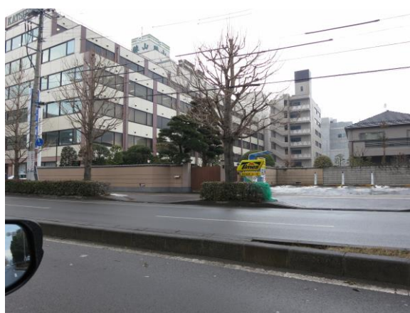
取り壊された
