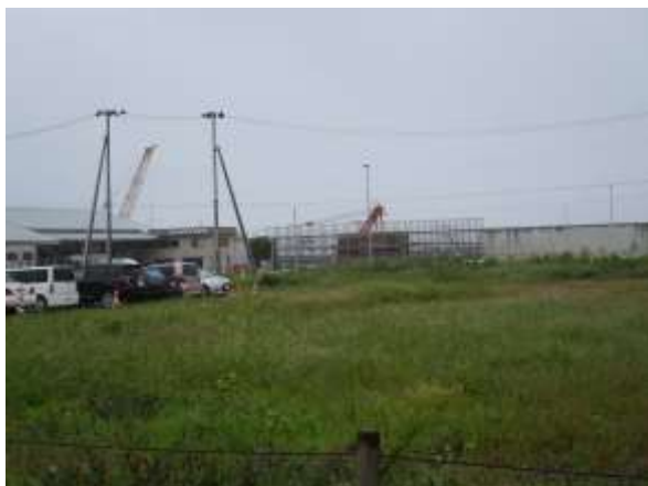
建設中の防波堤
