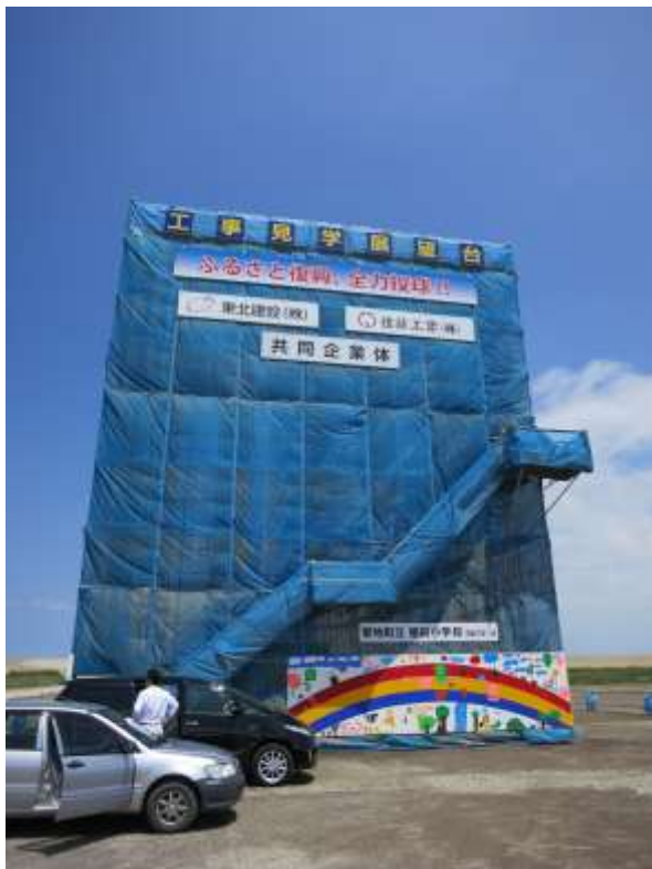
海岸近くに建てられた工事見学展望台から 6 年目でようやく整地が終了か
