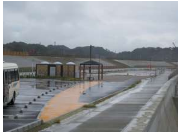
北側の海水浴場の駐車場
