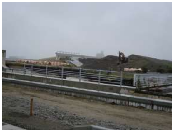
防波堤の被覆と緑化
