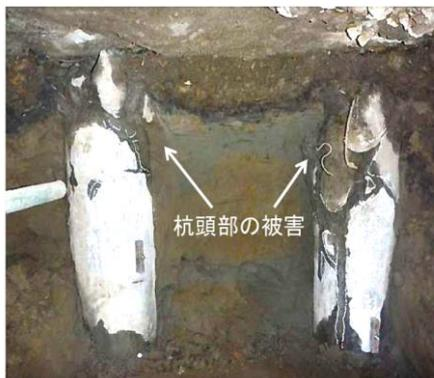
写真-1 地震による杭頭部の被害
