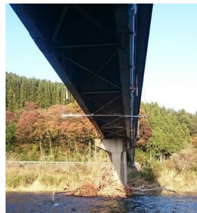
図-3 牛伏橋での点検風景
