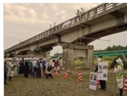
図-4 幸久橋での現場検証の様子 1)
