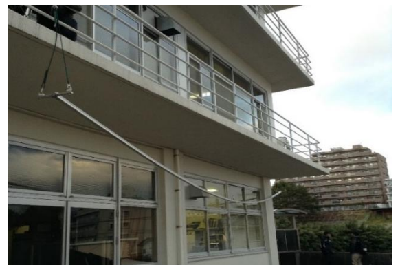
図-7 点検装置の試作品(長さ 12m)の設置
