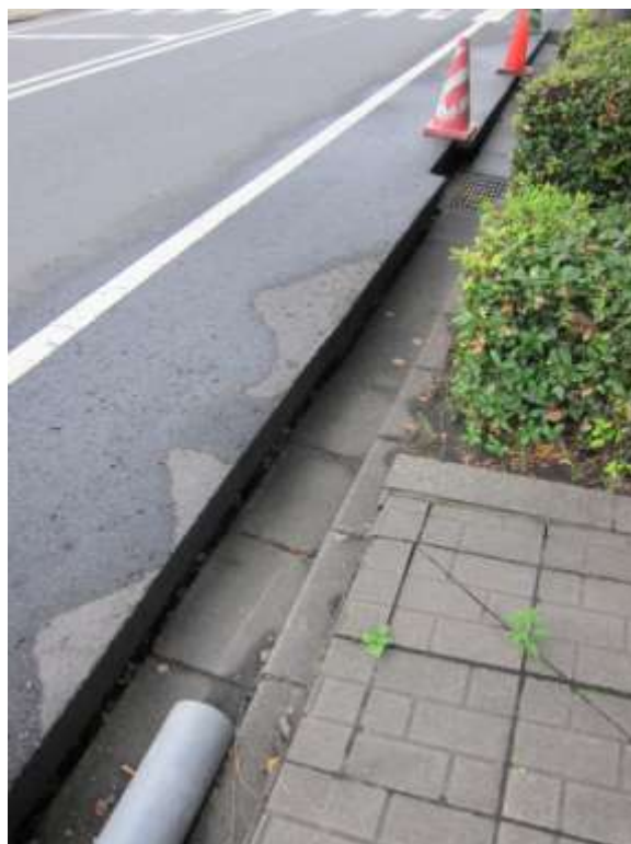
側溝の沈下
