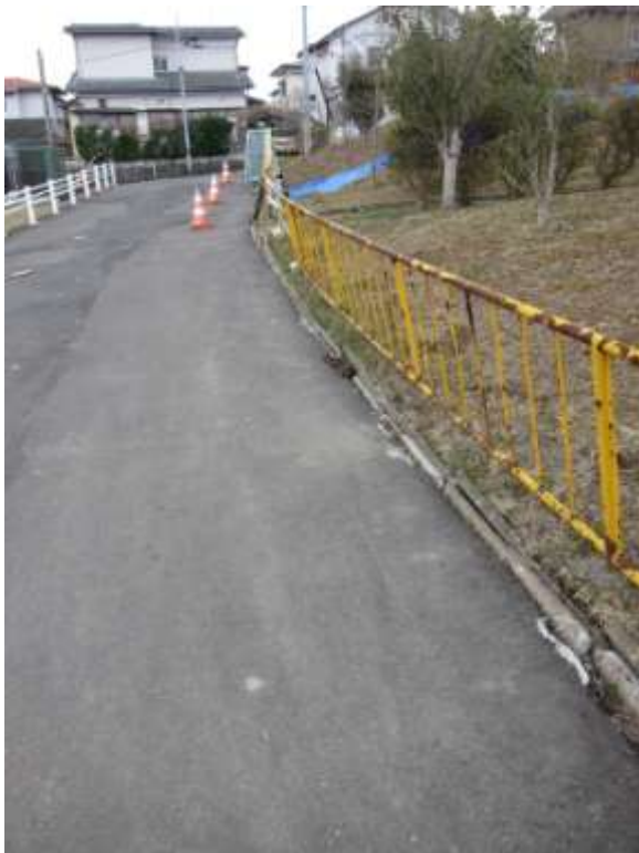
側溝をつぶして再舗装
