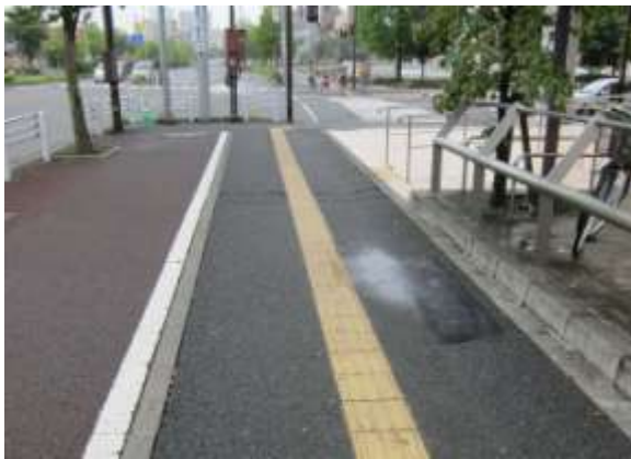
塞いだものの沈下が続く
