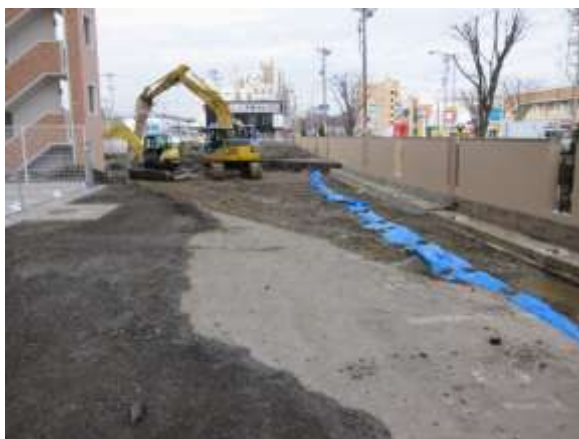
地盤改良（地下鉄路線上部分）
