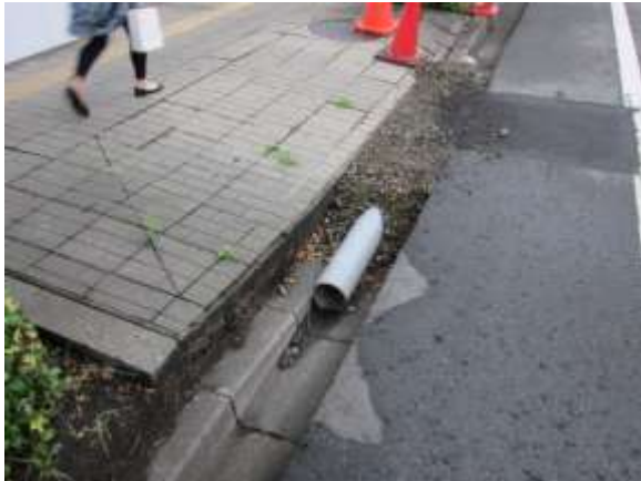
側溝に水を流す工夫
