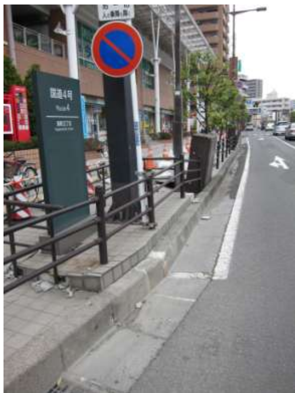
地盤沈下で傾いた道路占用物（長町）
