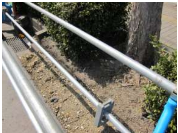
側溝が土で埋まっている
