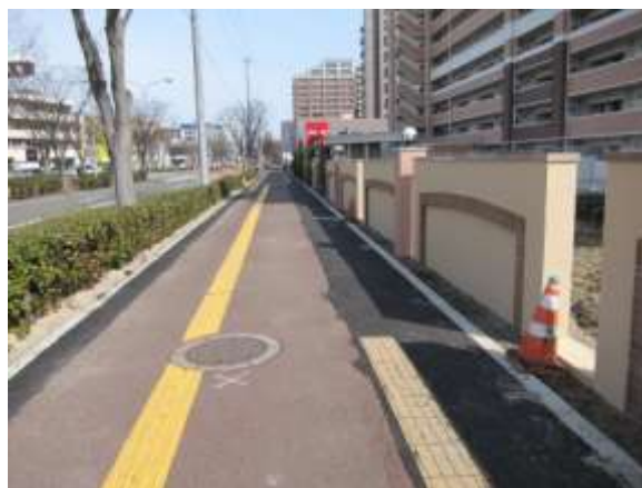
塀を水平に修復
