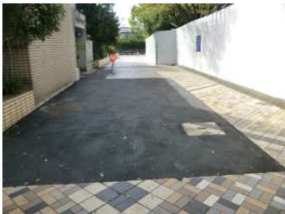
アスコンによる仮補修
