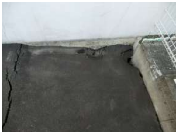
沈下と穴の拡大が進む
