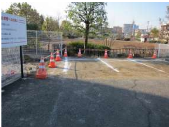
沈下した部分に土盛り
