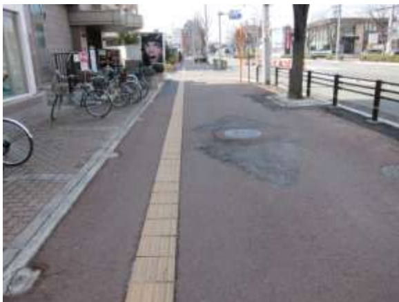
すりつけによる補修
