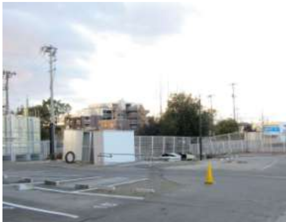
貯水槽を撤去
