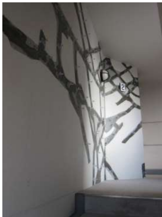
マンション内部の補修
