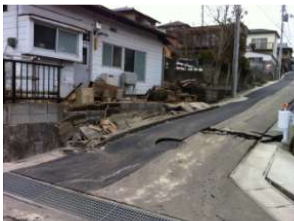
ブロック塀の倒壊（三浦上総君撮影）
