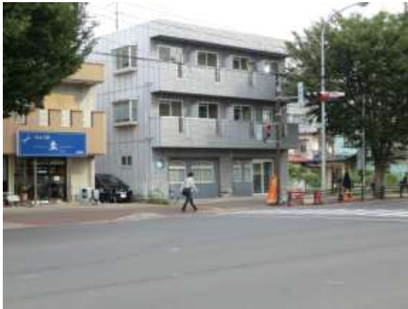
南面基礎と壁
