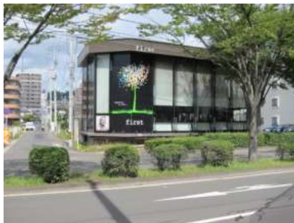
割れたガラス外壁を交換
