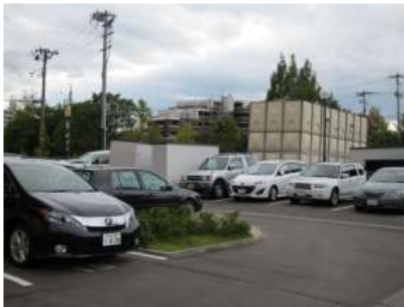
液状化で傾いた貯水槽
