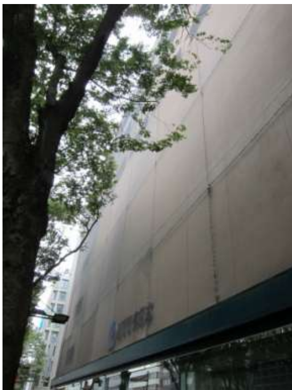
ネットで壁面を覆われたビル
