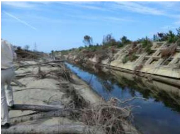
東側 堤防が変形しフレーム内の石がなくなっている
