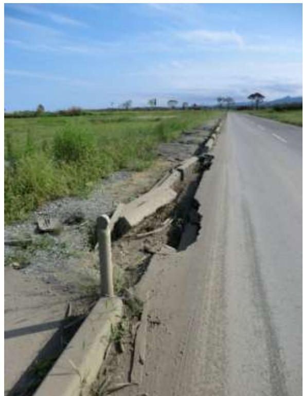
表層を剥がされ粒状材のみで仮復旧された舗装 凹凸が激しい
