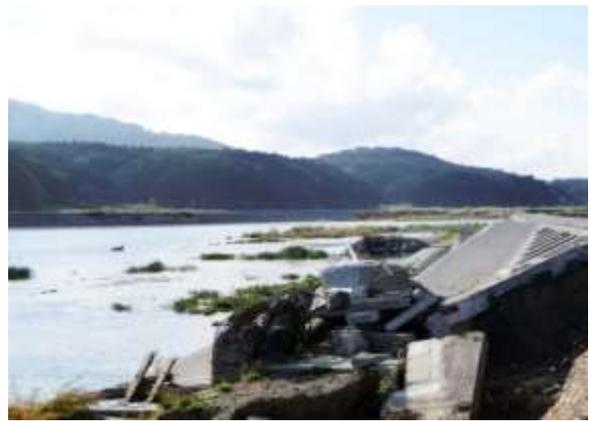
破壊された橋台際の堤防
