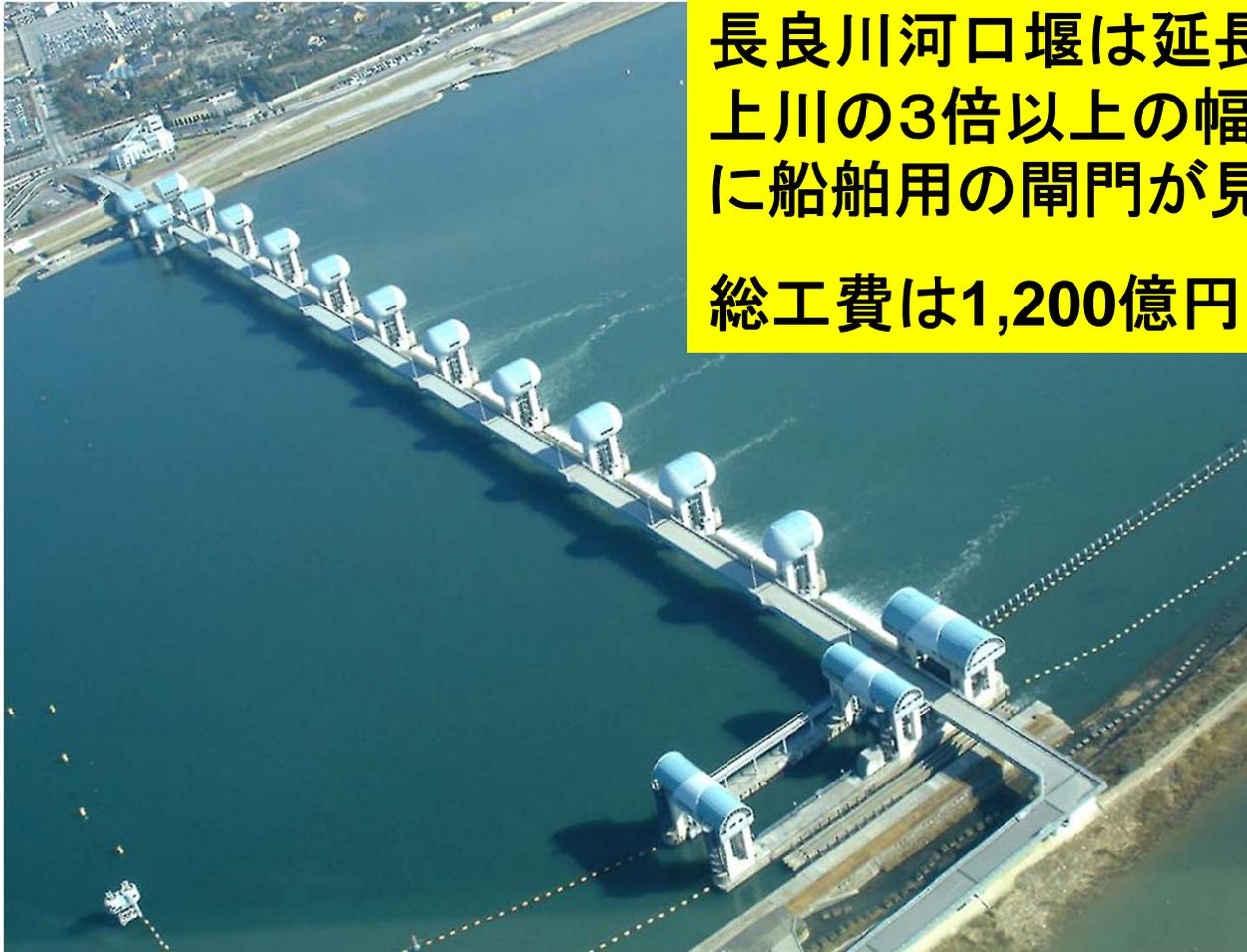
長良川河口堰は延長700mで北上川の3倍以上の幅である。右下に船舶用の閘門が見える。
