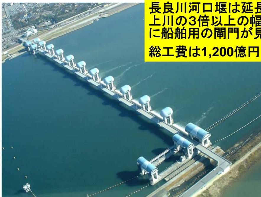
長良川河口堰は延長700mで北上川の3倍以上の幅である。右下に船舶用の閘門が見える。
