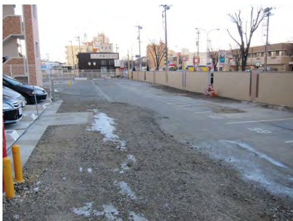
液状化に伴う駐車場の沈下
