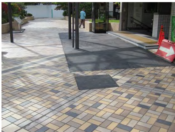
地下鉄出入口付近 アスコンによる仮補修
