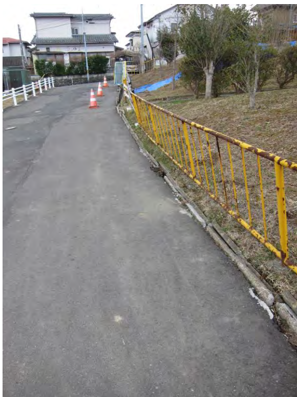
側溝をつぶして暫定舗装
