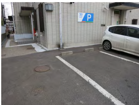
建物周りを修理，舗装はそのまま
