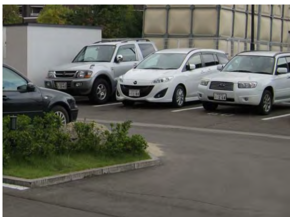
集められた駐車場の噴砂（植込みの中）
