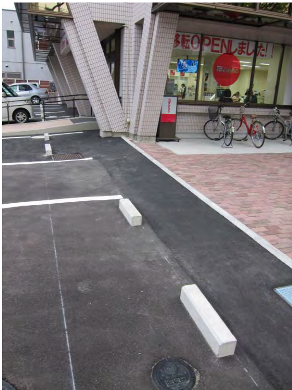
一旦はがして再舗装
