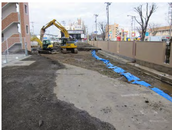
地盤改良（地下鉄路線上）
