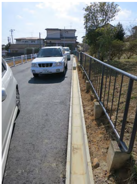
側溝を付け直して再舗装
