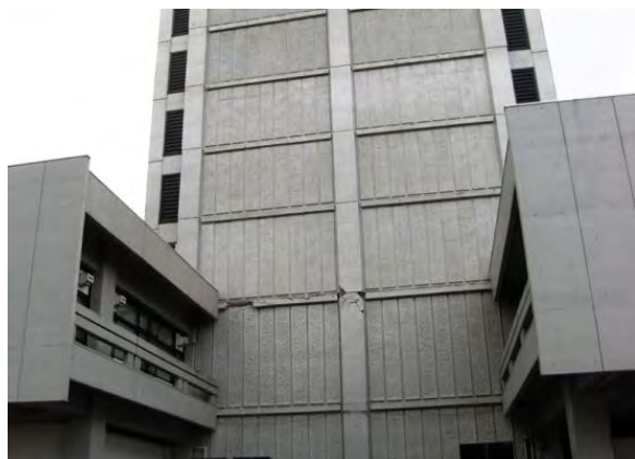
南側の柱の欠損（撮影：越後 滋氏）
