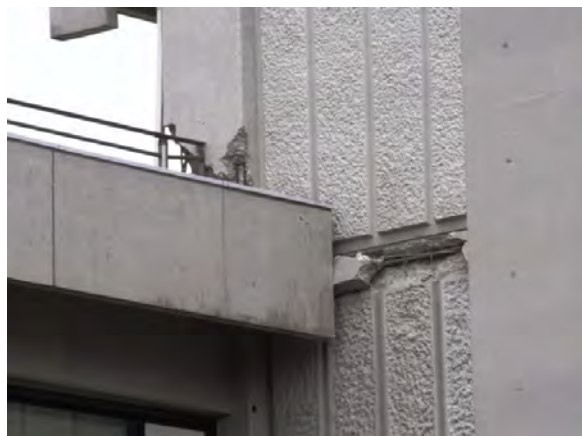
南側の柱の欠損（撮影：越後 滋氏）
