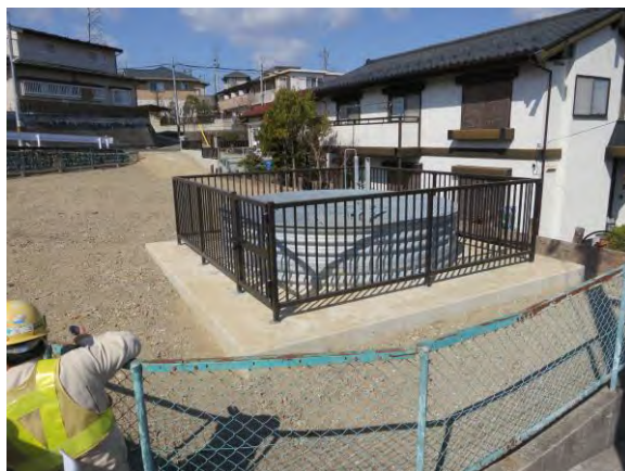
宅地内に幾つかの集水井が掘られた
