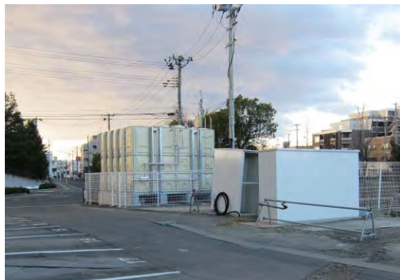
新しい貯水槽を設置
