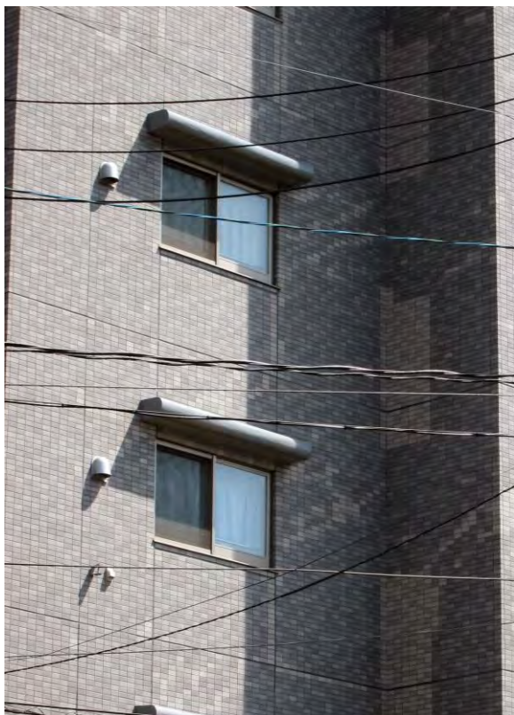
北西(上の写真左側)の壁面の修理跡
