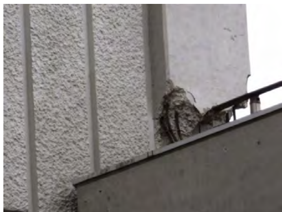
北側の柱の欠損（撮影：越後 滋氏）
