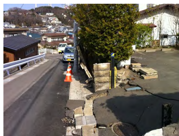
ブロック塀の転倒（三浦上総君撮影）
