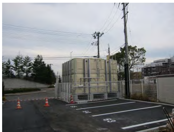
タイヤラックを移設後再舗装
