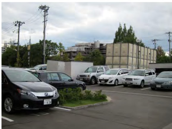
液状化で傾いた貯水槽
