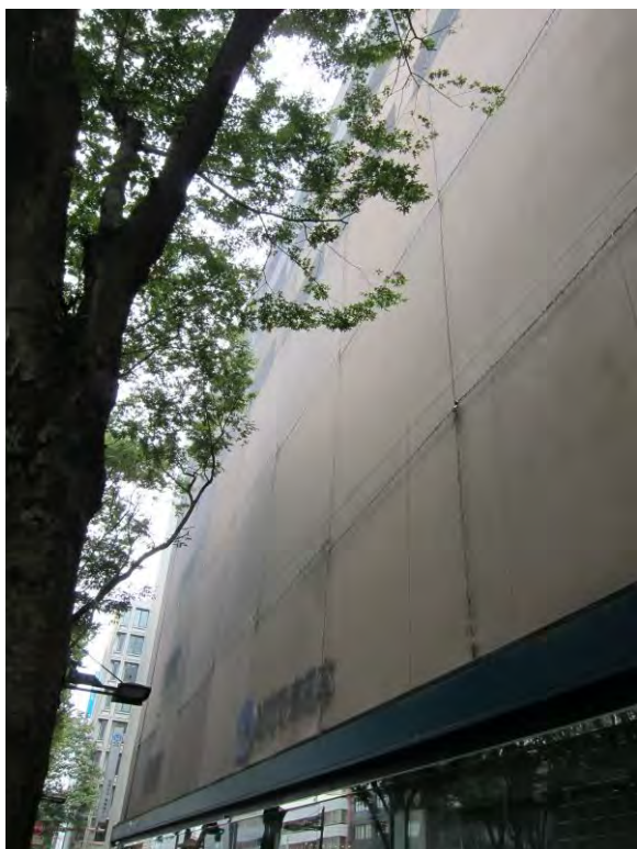
ネットで覆われた壁面
