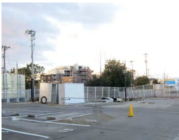
貯水槽を撤去
