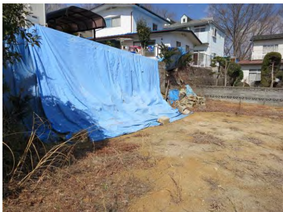
シートがかけられたままの擁壁
