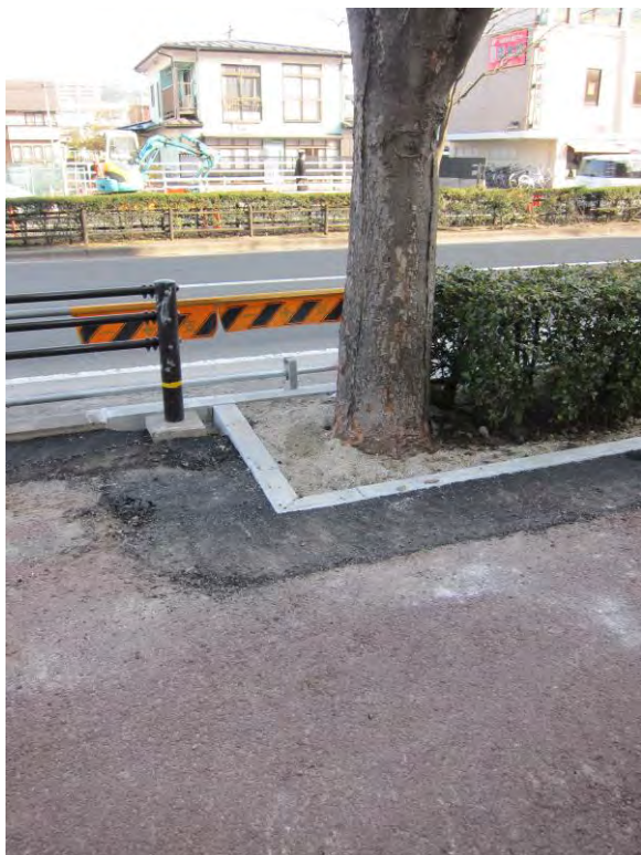
街路樹周りの縁石も交換
