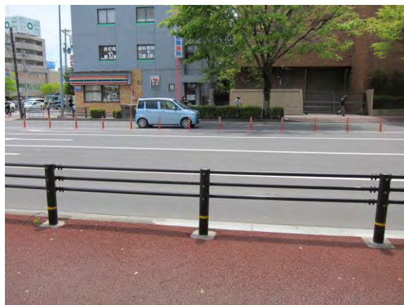
車道，歩道再舗装
