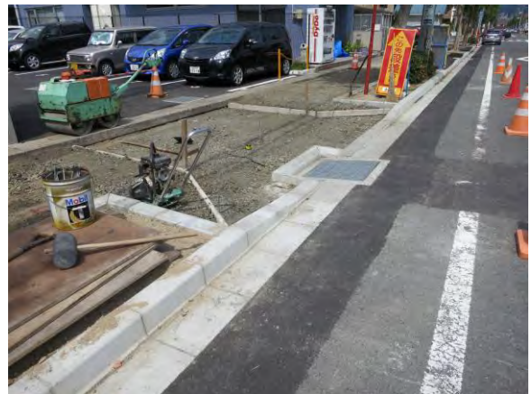
側溝を入れ直す
