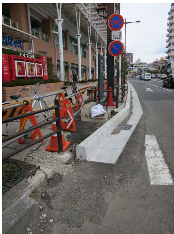
ようやく側溝が入れられた
