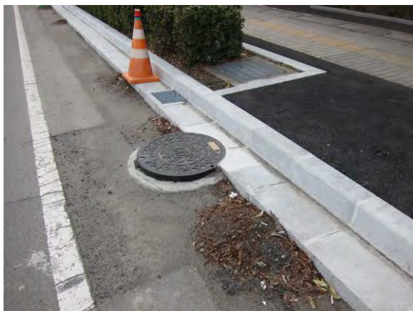
車道・歩道を補修（基層まで）
