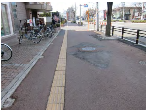
すりつけによる補修
