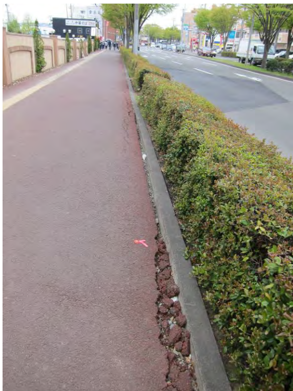
車道側に傾いた低木の街路樹
