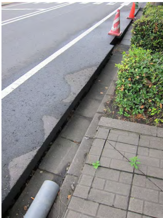
側溝の沈下
