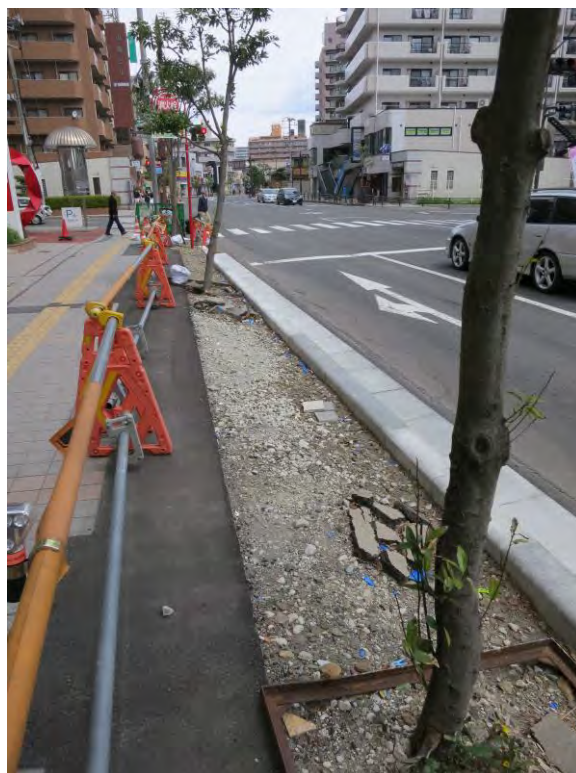
柵と平板を撤去
