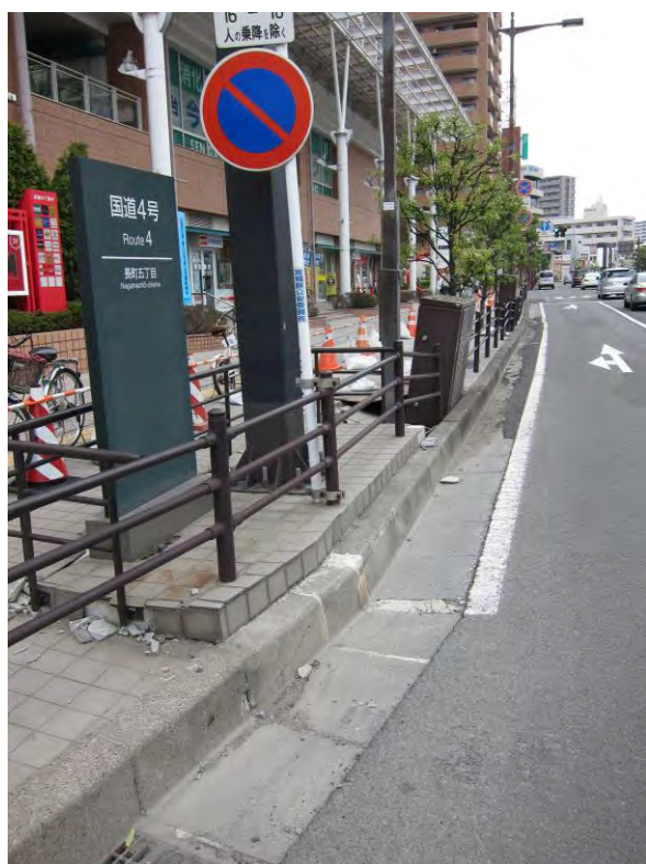
地盤沈下で傾いた道路占用物（長町）
