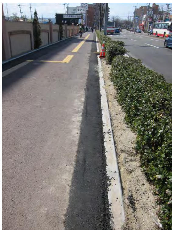
街路樹の縁石や土の入れ替え
