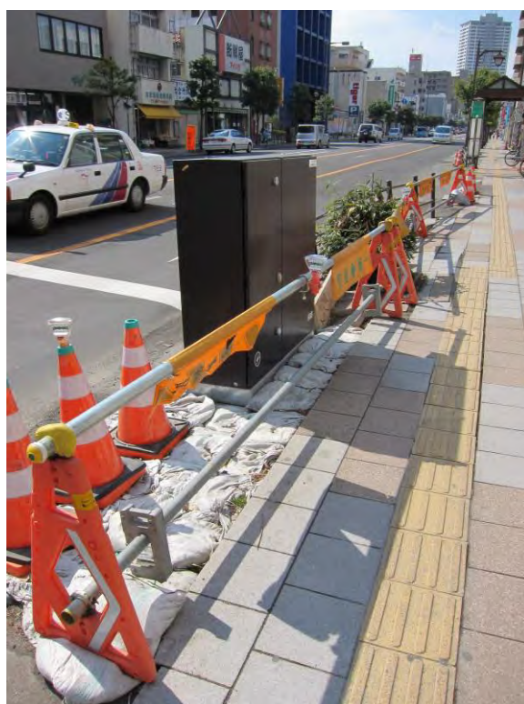
柵が撤去されただけ
