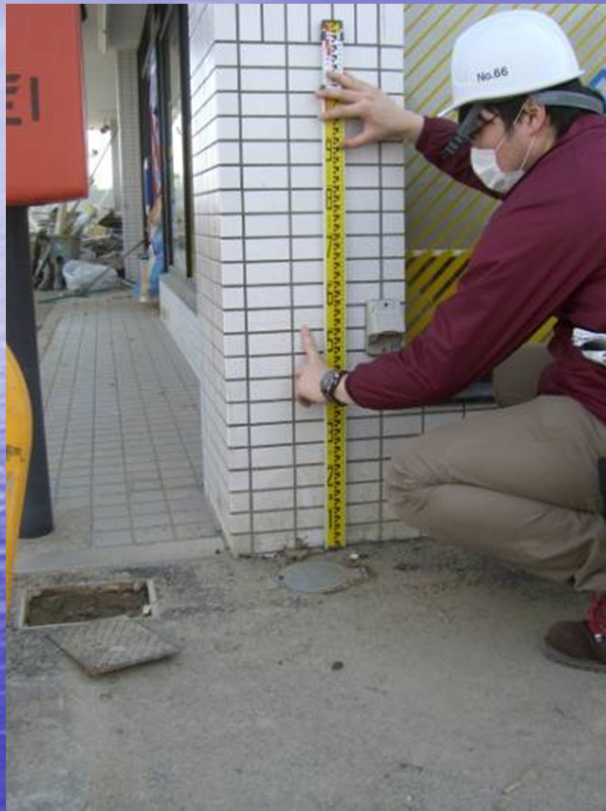
コンビニガラス一部損傷
